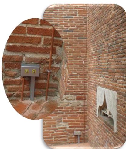
Nous apportons une attention spécifique au bas de la descente lors de la réalisation de la **prise de terre**. Nous utilisons un joint de contrôle et une protection mécanique spécifiques.
