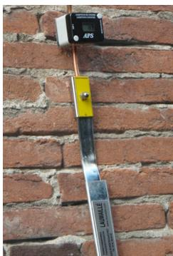
Pour montage et démontage du compteur, le conducteur de descente n'a pas besoin d'être coupé. Par contre, il faut ouvrir le joint de contrôle (situé au dessus ou au dessous du compteur) afin de dégager le conducteur de la façade et pouvoir démonter les 2 vis et la bride en partie arrière.
