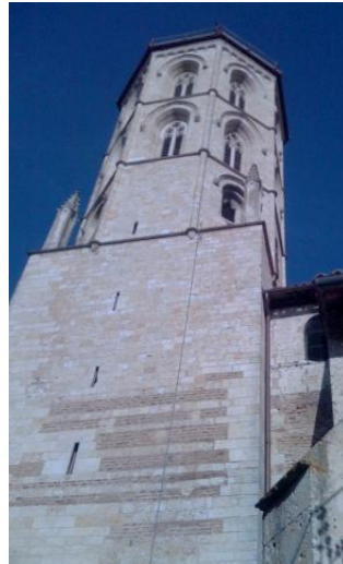
Conducteur de descente sur le côté du clocher
