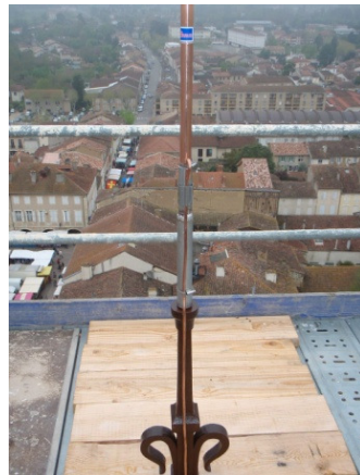
... et après travaux
