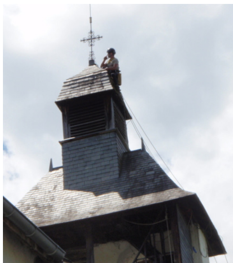
Intervention sur cordes
