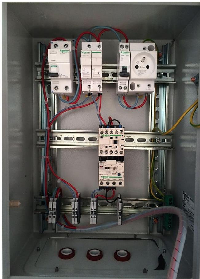
Comprenant interrupteur de puissance + contacteur de sécurité + borniers + sectionneur fusible protection des commandes + 2T + 1C + coup de poing d'arrêt d'urgence
