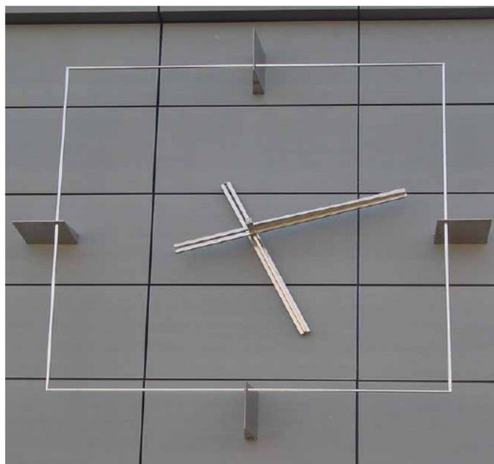
22 cadran moderne en acier inoxydable installé sur la façade d'un édifice
