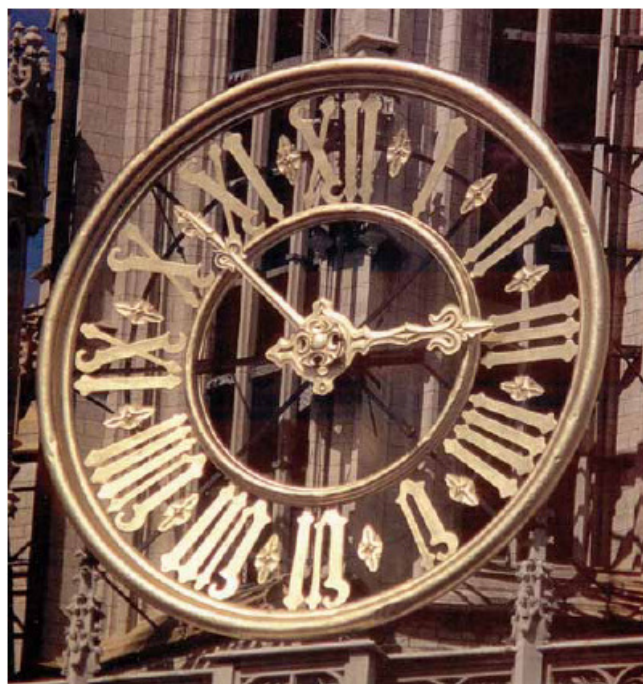
2 cadran squelette restauré diamètre 6.9 mètres
