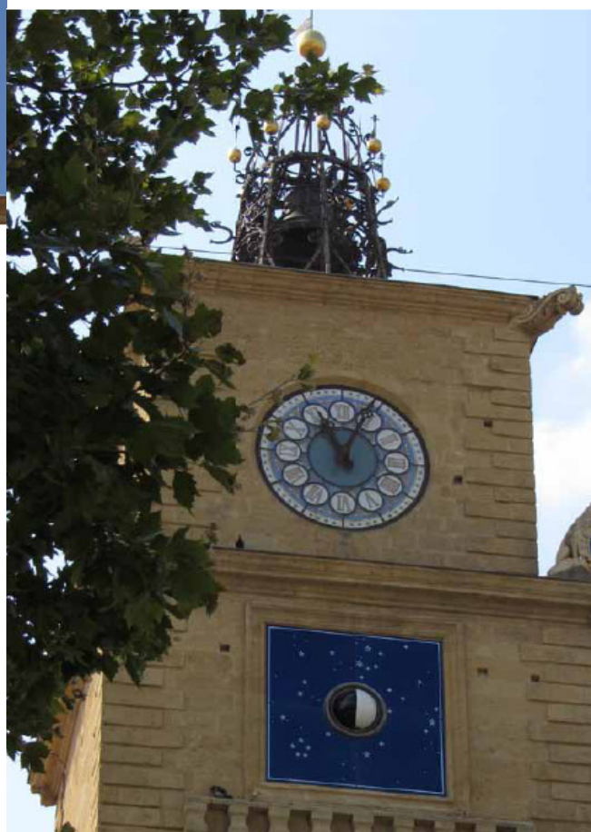
50 horloge astronomique - commande à l'aide d'une horloge-mère Apollo avec logiciel adapté - indication des phases de la Lune
