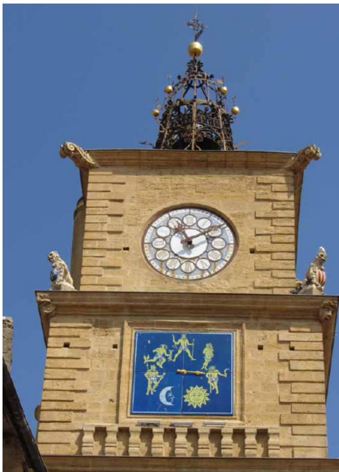
49 horloge astronomique - commande à l'aide d'une horloge-mère Apollo avec logiciel adapté - indication des jours de la semaine
